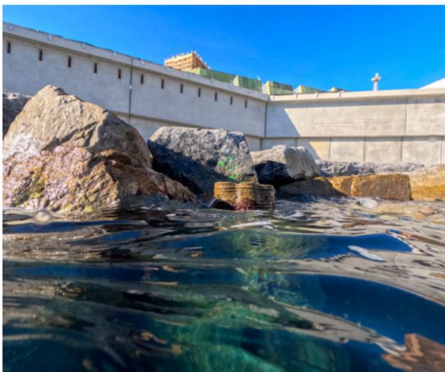
Figure 4 : Bloc de digue, mimant les cuvettes naturelles, destiné à l'accueil d'une algue brune la cystoseire, en béton imprimé 3D à Monaco (photo : Direction de l'Environnement)
