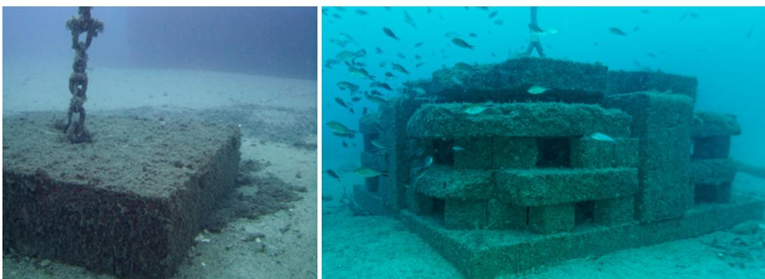
Figure 15 : A gauche l'ancien coffre, ouvrage cubique « classique » à droite le lest éco-conçu, noter les bancs de poissons présents sur la structure éco-conçue qui fournit un habitat de type coralligène (photo : Direction de l'Environnement-Monaco)
